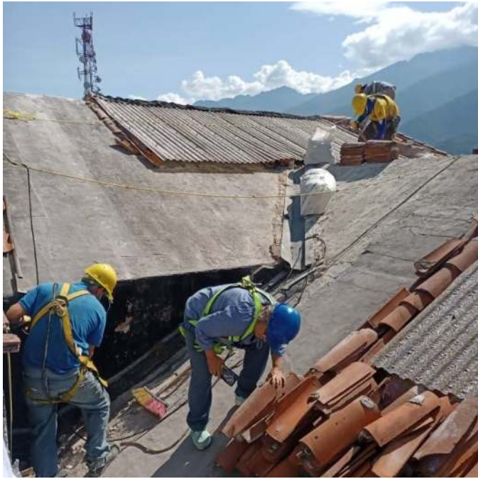
Figura 9. Personal colocando teja e impermeabilizando Fuente: Klaudia Laffaille (2024)
