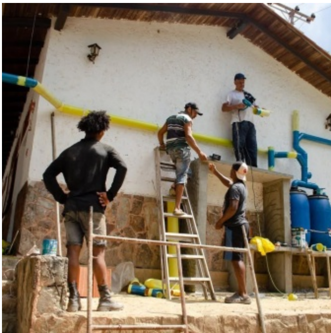
Figura 3. Sistema de captación de agua de lluvia en Chichiriviche de la Costa, estado La Guaira Fuente: @latadeagua_ (2022)
