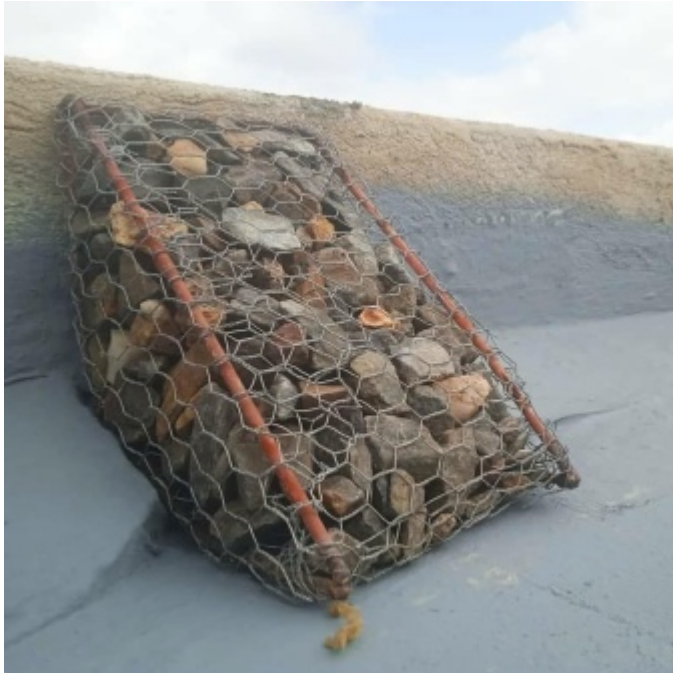
Figura 2. Filtro de piedra (nasas) para retener residuos grandes, como hojas o suciedad Fuente: @latadeagua_ (2020)
